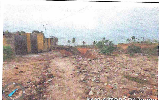
Local da Erosão
