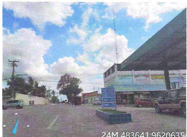
Final do Trecho Contemplado da Av Maria Moreira
