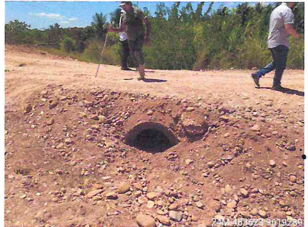
Manilha de bueiro aterrada no final do trecho, local do lançamento da água na rede atual.
