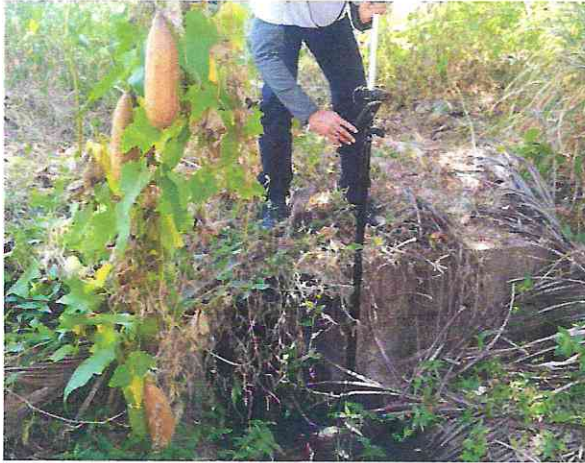
Bueiro capeado existente no final do trecho, que será usado para lançar a água da rede projetada.
