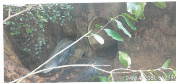
Bueiro existente no Trecho
