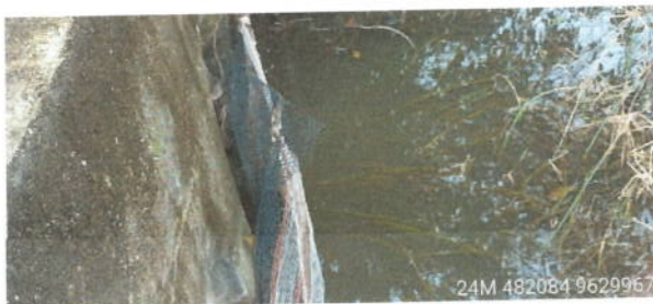
Bueiro existente no Trecho
