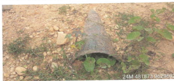
Bueiro existente no Trecho
