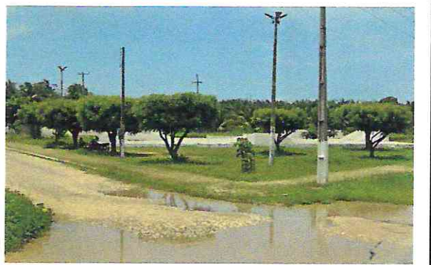
Vista da área a ser requalificada.
