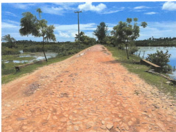
Vista geral do bueiro existente
