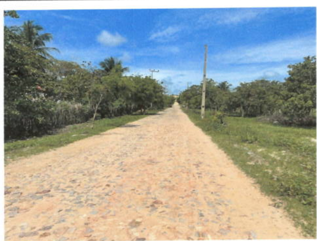
Vista geral da estrada
