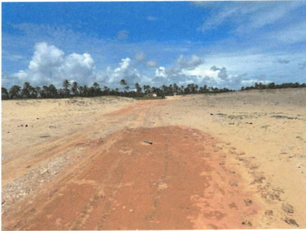
Vista geral da estrada e do trecho a ter substituição de material
