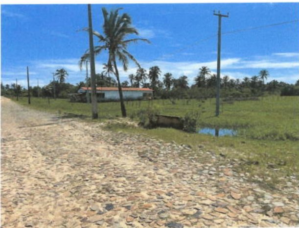
Vista geral do bueiro existente
