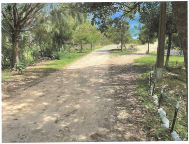
Vista geral do bueiro existente
