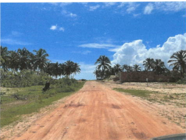
Vista geral da estrada próxima a estaca final
