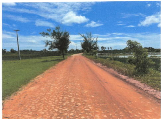
Vista geral da estrada
