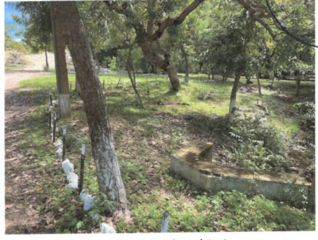
Vista geral do bueiro existente
