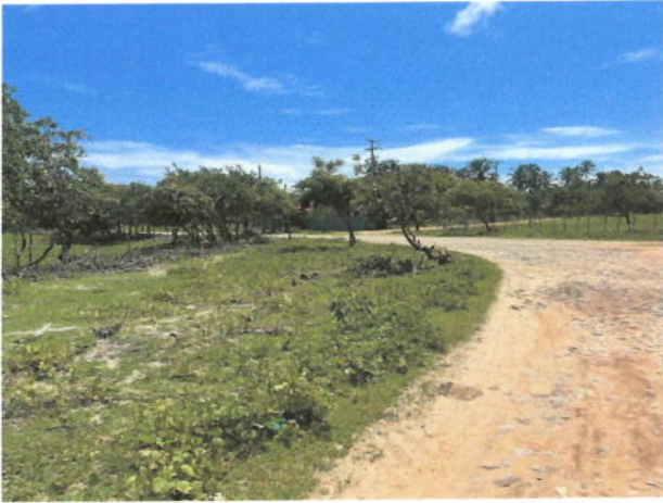
Vista geral da estrada
