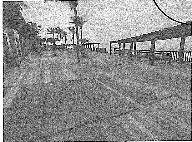
Vista do piso em madeira existente a remover
