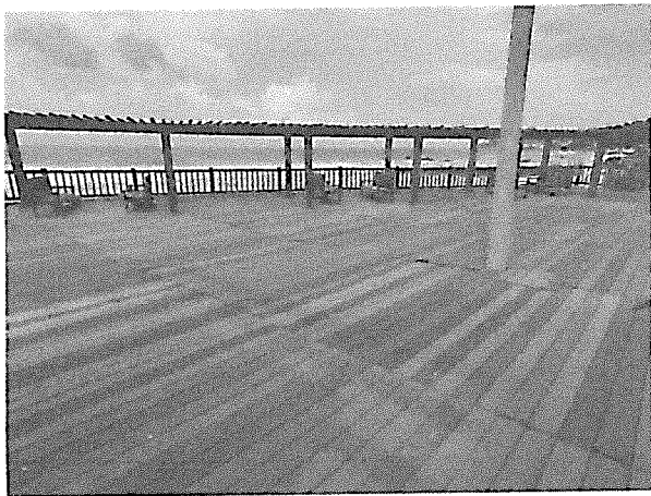
Vista do piso em madeira existente a remover
