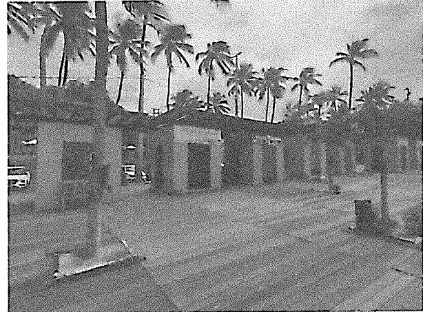
Vista dos quiosques a serem demolidos
