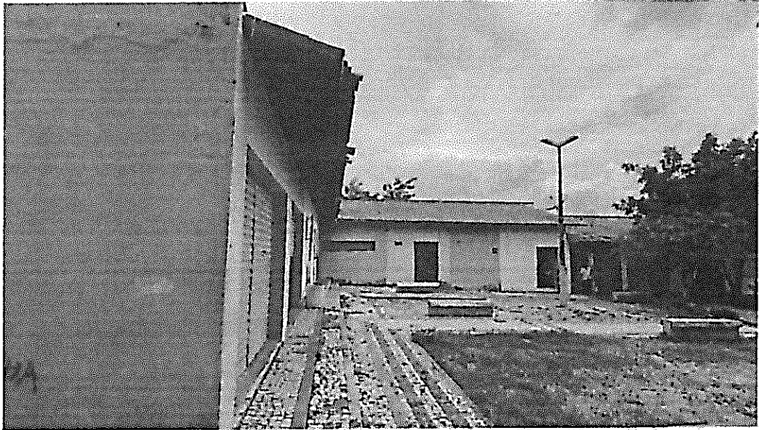
Vista da pracinha, ao fundo, pontos comerciais.
