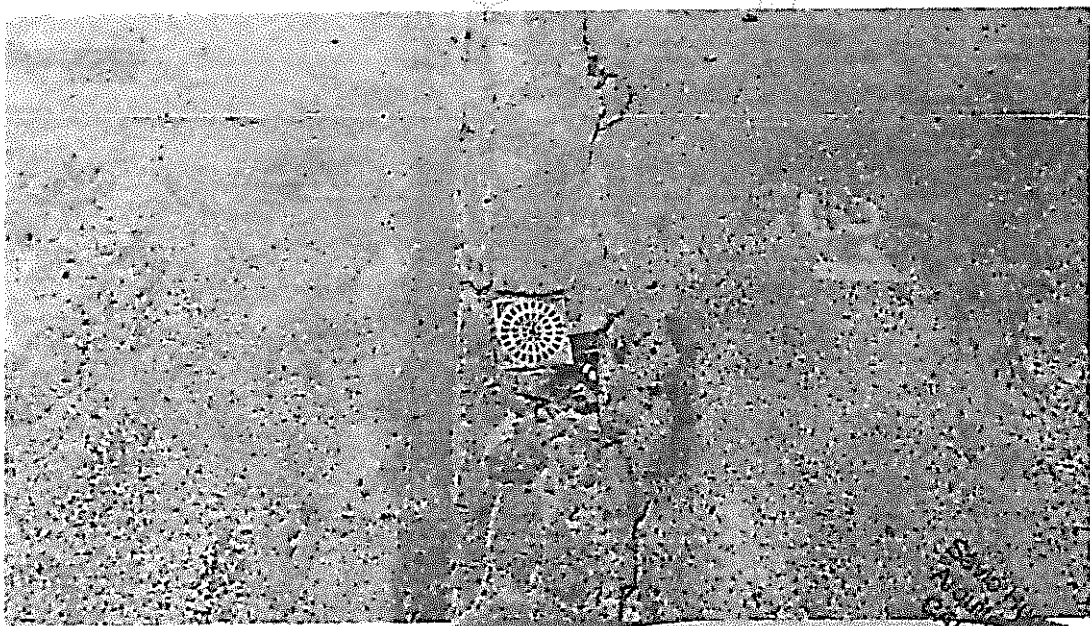
Estrutura metálica – Mercado dos cereais. Piso industrial danificado.
