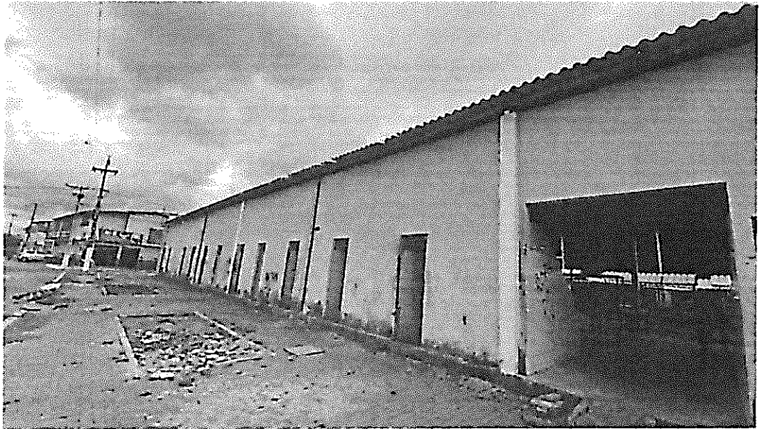
Fachada lateral do Mercado da carne.
