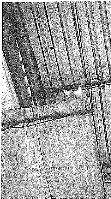
-Estrutura de cobertura danificada, muitas folhas quebradas.
