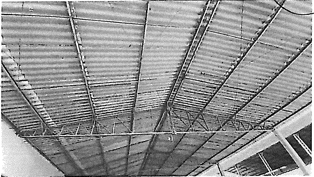
Estrutura de cobertura – Mercado da carne.
