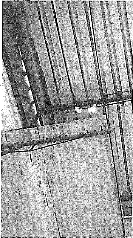
-Estrutura de cobertura danificada, muitas folhas quebradas.
