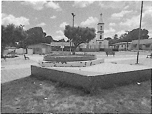
Vista geral da praça..
