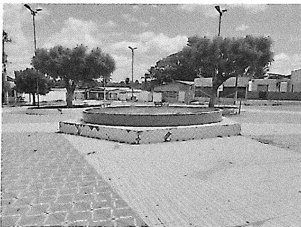
Demolição de piso e alvenarias a demolir
