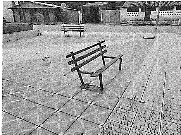
Retirada de equipamentos e demolição de piso
