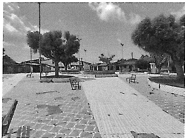
Demolição de piso e alvenarias a demolir
