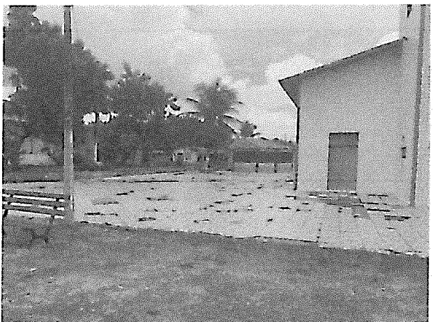
Vista geral da praça; Piso a ser demolido.
