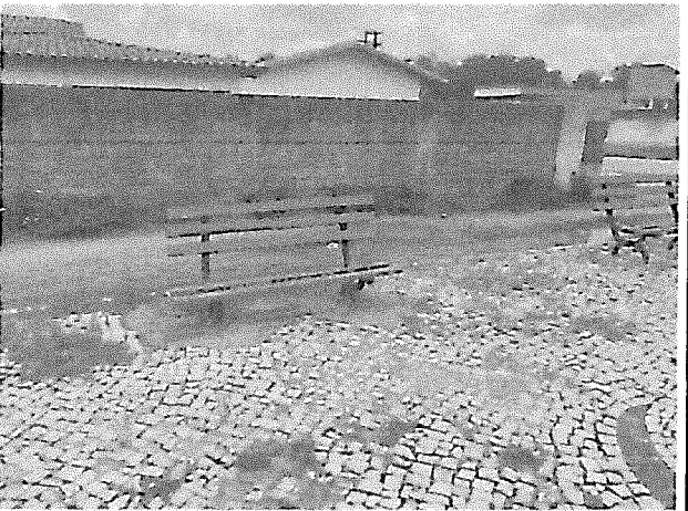
Retirada de equipamentos e demolição de piso
