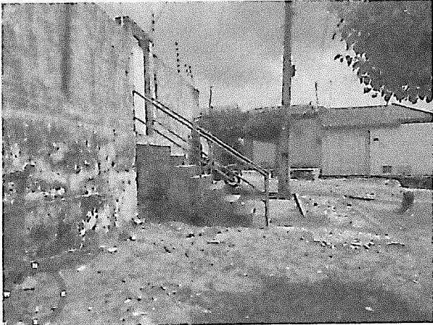
Visão da escada existente
