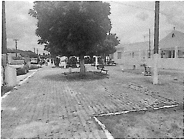
Vista geral da praça, área para limpeza.
