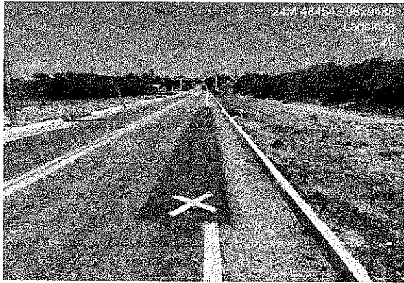
Vista Acesso pelo início do trecho CE-162
