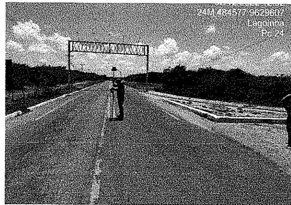
Vista Do Pórtico existente
